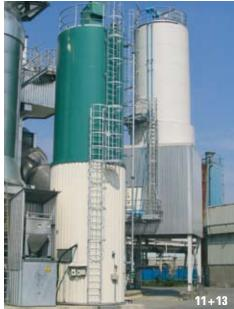
Dann werden Stoffe hinzugegeben, die Schadstoffe durch chemische Reaktion neutralisieren (9): Feinstgemahlenes Bicarbonat (11), das die so genannten sauren Bestandteile bindet, sowie fein pulverisierte Aktivkohle (12), die mögliche Spuren von Dioxinen, Furanen und polycyclischen aromatischen Kohlenwasserstoffen bindet und darüber hinaus mögliche Spuren von Quecksilber entfernt.
